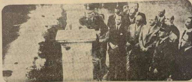
El interventor federal, general Alberto Guglielmo, en el momento de iniciar simbólicamente la demolición de las edificaciones que serán afectadas por las obras de Sistemización de La Cañada
