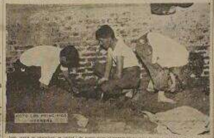
Se están preparando para la voladura del puente de Calera, en Alto Alberdi.
