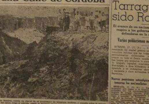
En el sitio donde estaba una calle de Córdoba, se ve ahora un muro de lodo que impide el tránsito de los vehículos y a los peatones.
