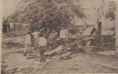
En Pueblo Güemes, se ve el estado de las cosas tras el terremoto del domingo. El agua ya inundaba las calles, y se ven los restos de las casas destruidas.
